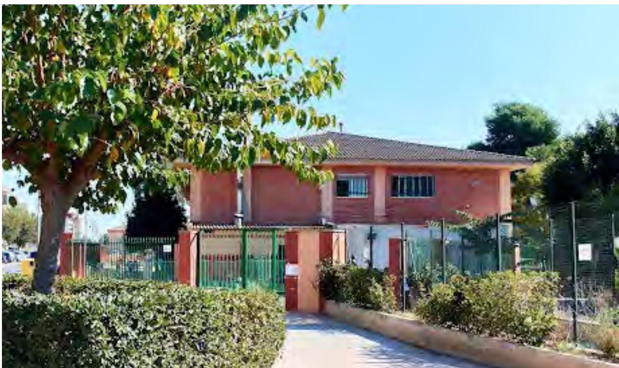
Façana CEIP Blasco Ibáñez
