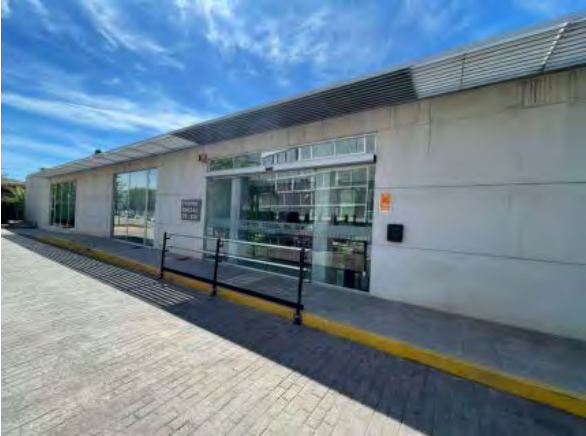
Façana Centre Administratiu
