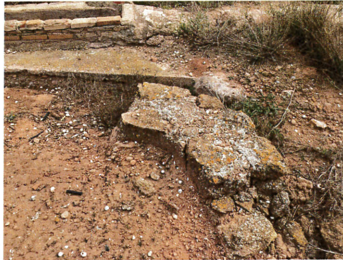
Detalle de la estructura en uno de sus extremos.
