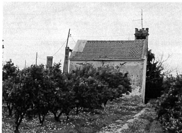
Motor del Torrubero, y detrás la torre eléctrica del motor Nou.
