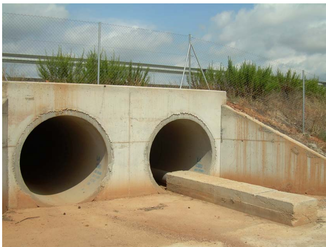
15. Drenaje vía de servicio 2 tubos \phi 1800mm
