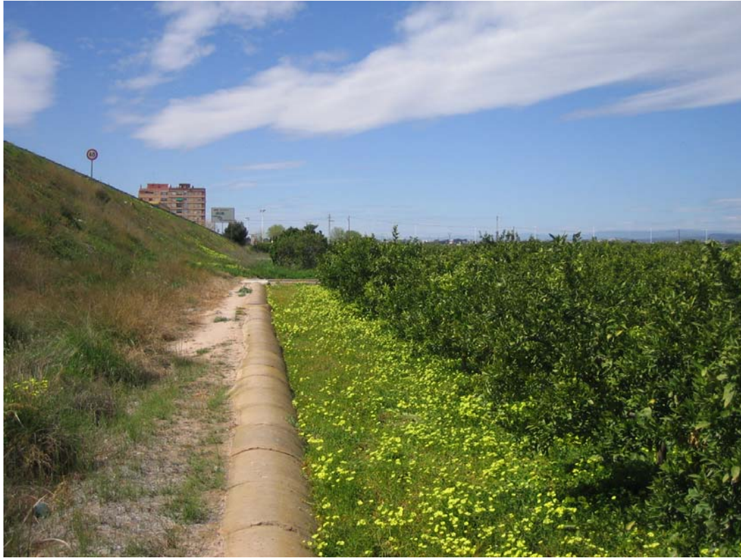
24. Ubicación del canal de evacuación vista hacia agua arriba.
