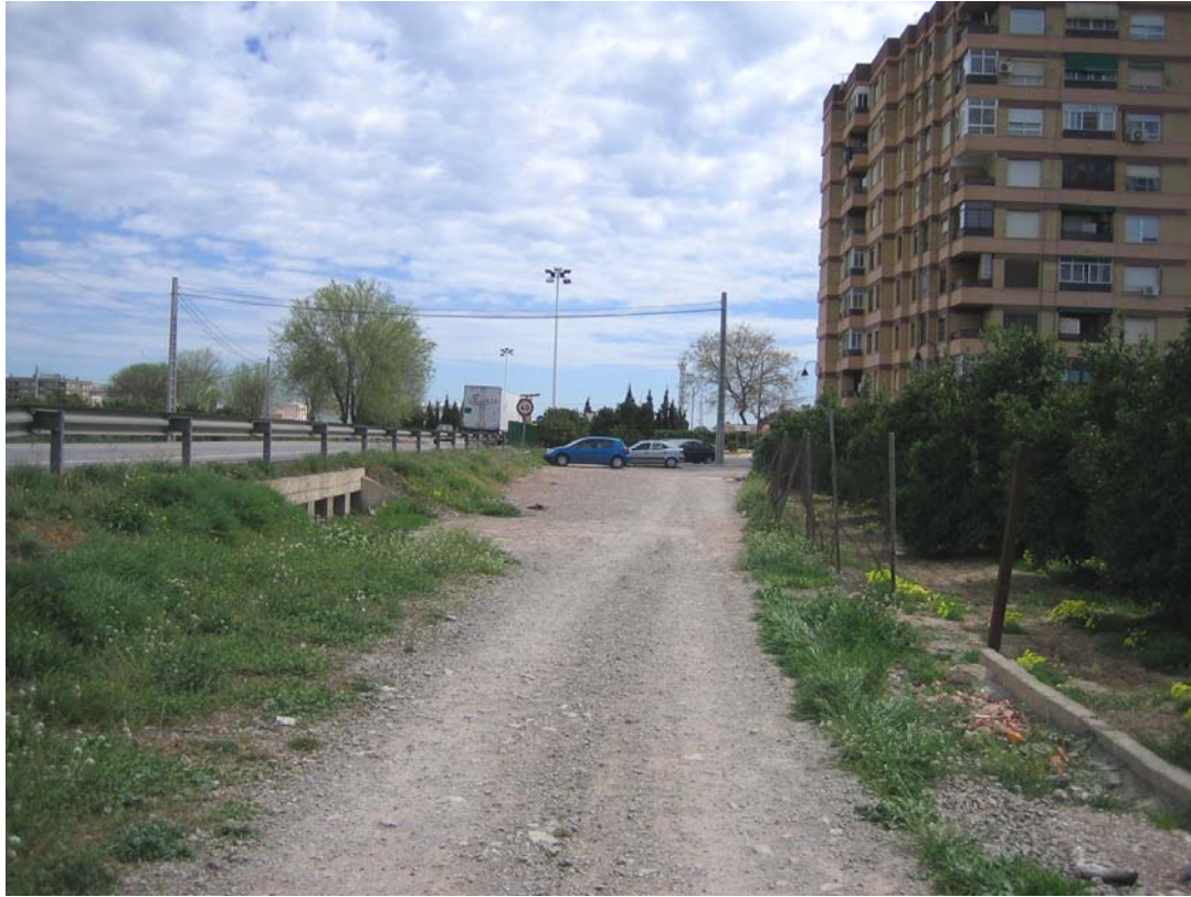
22. Drenaje actual de la CV32 junto al núcleo urbano de Museros con 6 Marcos de 1.2 x 0.6 m.
