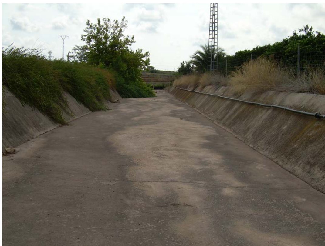
4. Aguas abajo de la estructura de drenaje anterior.
