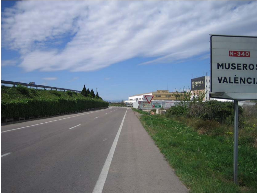
26. Ubicación propuesta del canal de evacuación vista hacia agua arriba. Zona final
