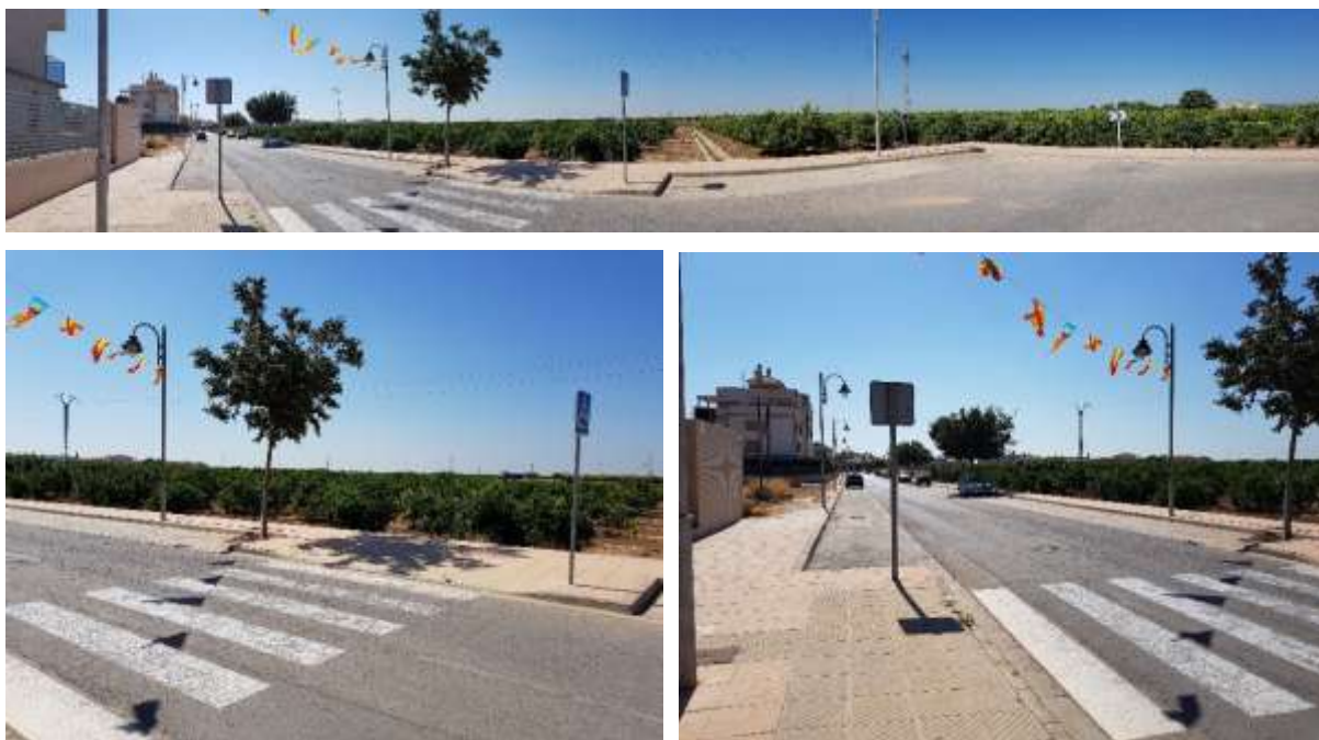
Vistas del vial de borde del Sector S6, con el de nuevo desarrollo ZND-RE-1
