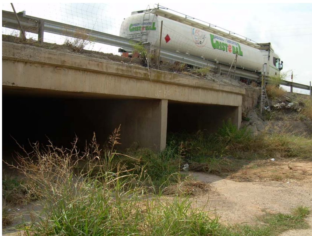
3. Barranco de Museros bajo la A7 mediante dos marcos de 4 x 1.8 m.
