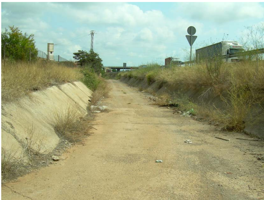
2. Barranco de Museros recogido mediante canal paralelo a la A7.
