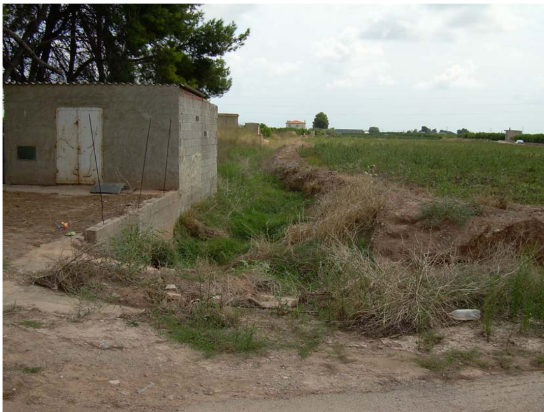
7. Lugar donde prácticamente desaparece el cauce vista hacia aguas abajo
