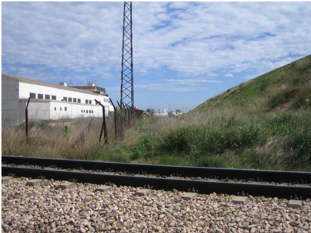
25. Idem. anterior visto hacia aguas abajo en el cruce con la línea de FGV.
