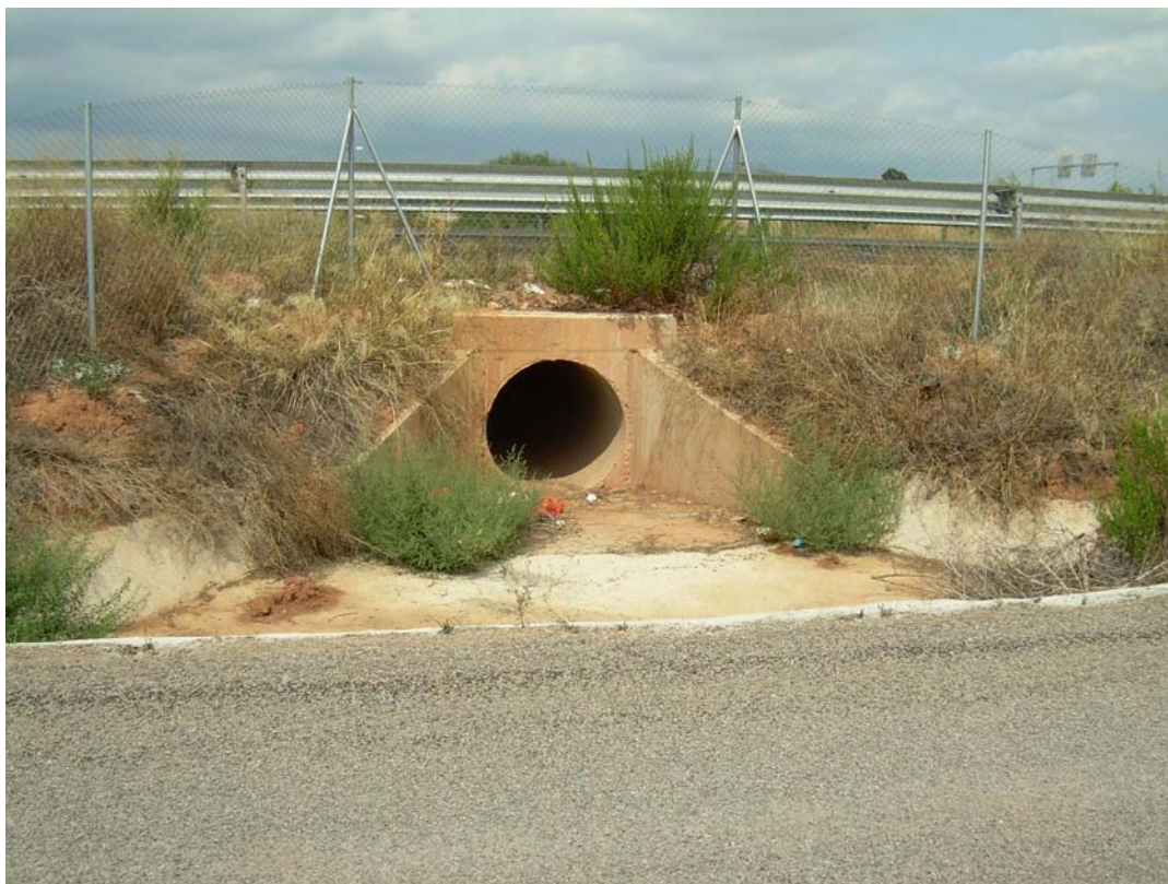
16. Drenaje vía de servicio. 1 tubo \phi 1200mm.
