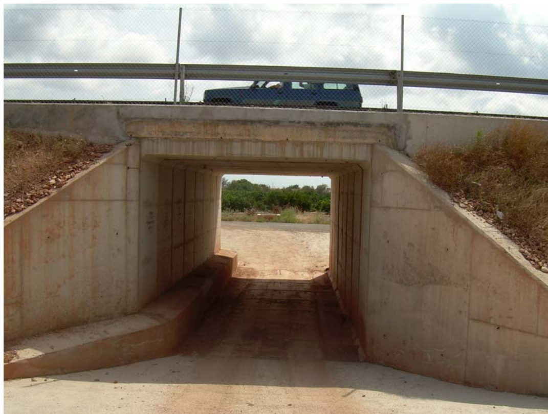
14. Drenaje vía de servicio. Marco 4 x 3.5 m.
