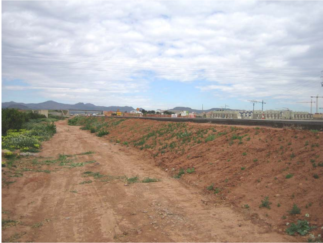
20. Zona donde se acumula la escorrentía debido a la CV32 Ubicación para el canal Interceptor
